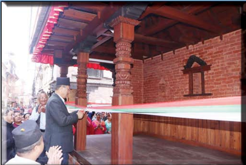
पुनर्निर्माण सम्पन्न षडा नं. ५ भोलाछैको पाटी
