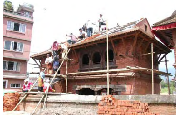
निर्माणाधिन आदर निकेतन भवन
