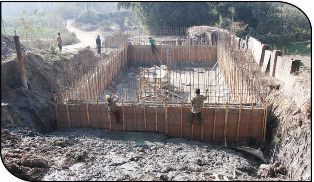
ढाला खुशीमा निर्माणाधीन ३ लाख लिटर पानी झुट्ने दयाङ्की
