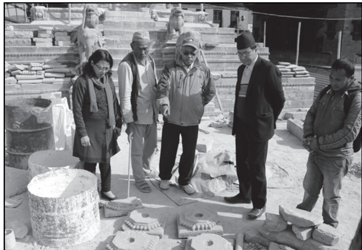
प्रमुख सुनिल प्रजापति, उपप्रमुख रजनी जोशी लगायत भक्तपुर दरबार स्वचायस्थित वत्सला मन्दिरको निर्माण कार्यको अवलोकन निरीक्षणमा।
